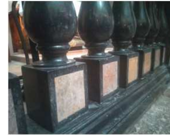
Chiesa dei Cappuccini (To), pilastrini
