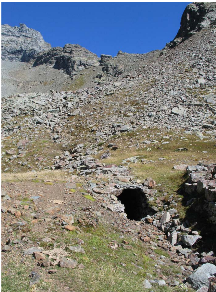
Ingresso di traverso-banco ostruito di una miniera cobaltifera settecentesca a oltre 2400 metri di quota.
