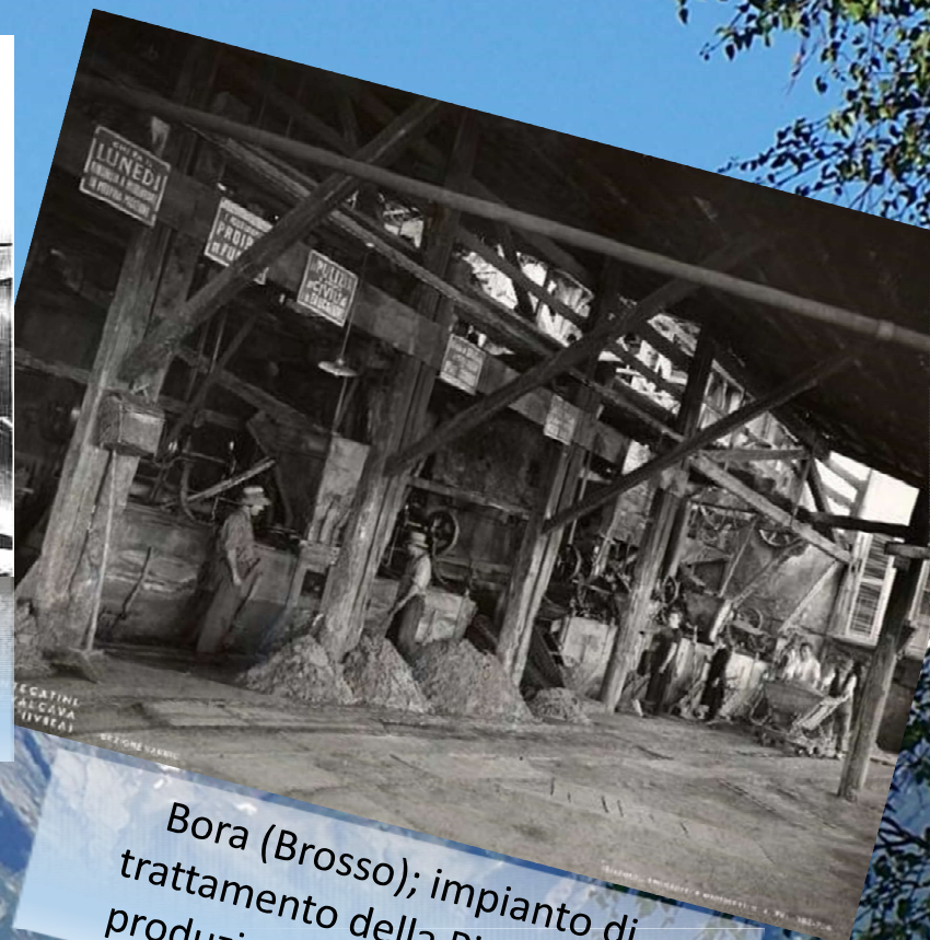
Cernita del minerale tramite i «piani a scossa», a Traversella, come li vidi in funzione.
